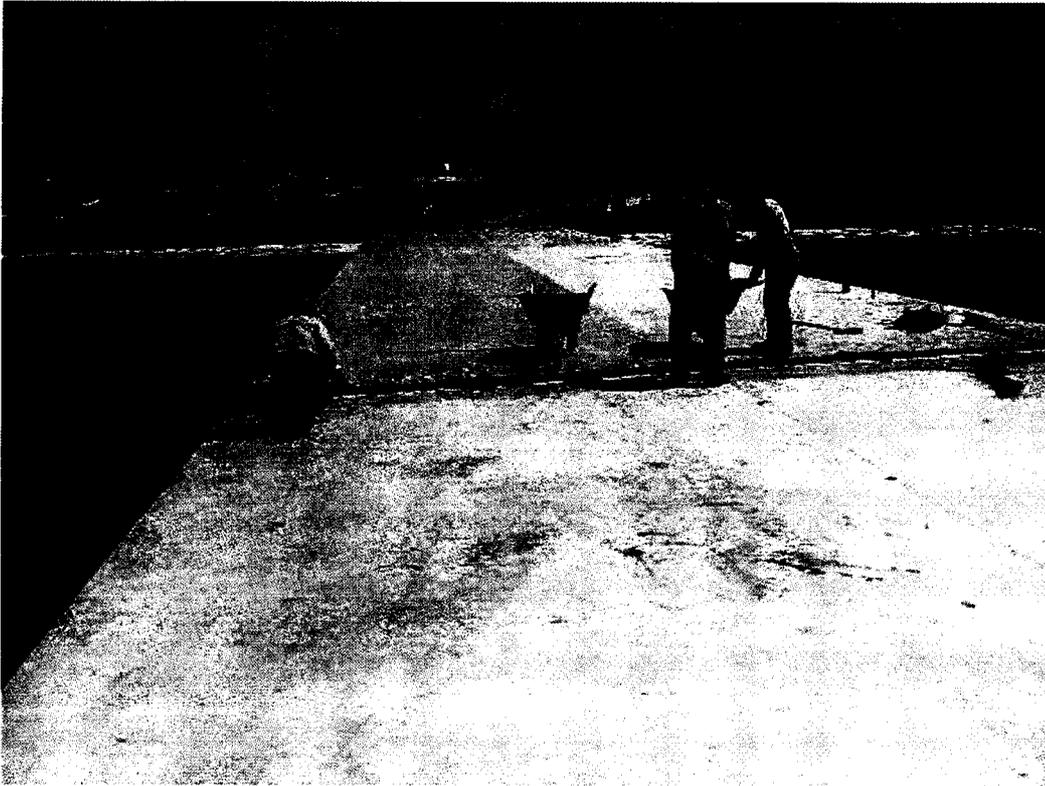
Foto N° 7.10 Colocación de juntas en muelle
