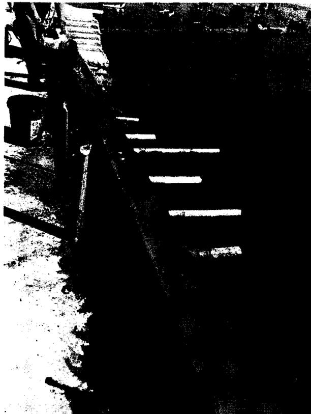
Foto N° 7.11 Curado de las vigas de borde con agua al momento del desencofrado
