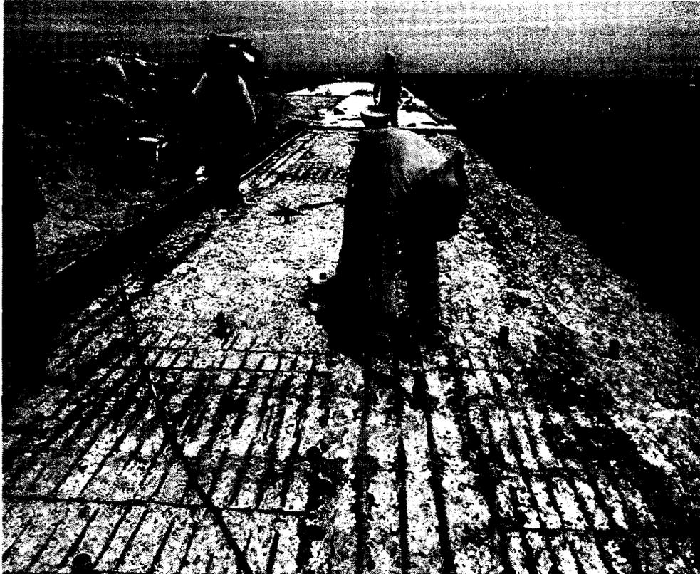
Foto N° 7.4 Limpieza de acero con transformador de óxido – Muelle CANCAS
